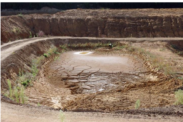
Photo 9 : bassin de décantation dans la partie nord de la carrière (13/09/2019)
